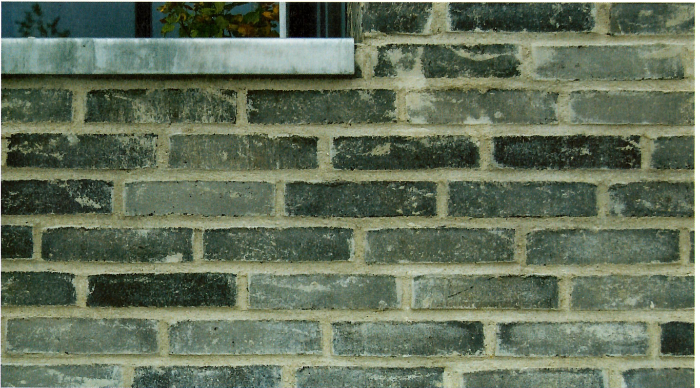
Variationer fra grå til næsten sorte mursten. Fugen er færdiggjort under opmuringen. Murværket er ikke afsyret.
