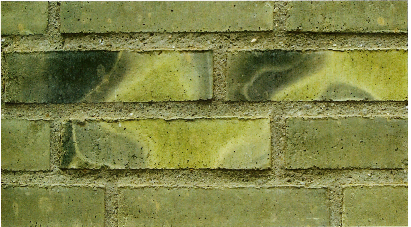
Grådæmpede mursten med spil. Fugen er trykket og færdiggjort med indfarvet mørtel under opmuringen.
