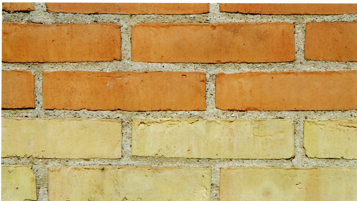
Kombination af røde og gule, blødstrøgne mursten. Trykket fuge med bakkemørtel, der er færdiggjort under opmuring.
