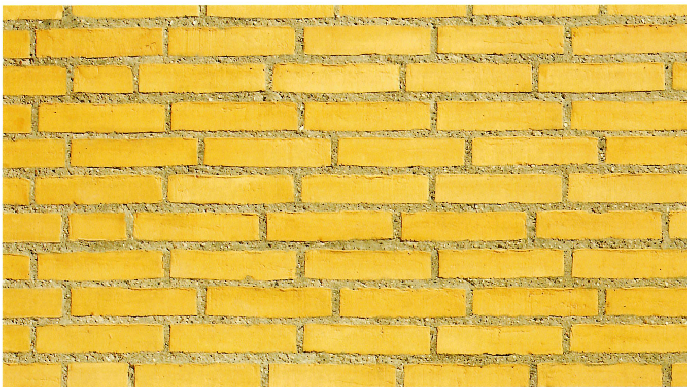
Gule, blødstrøgne mursten opført i 1/4-stens løberforbandt. Fugen er udkradset under opmuringen og efterfølgende færdiggjort som skræbefuge i en grovkornet bakkemørtel.
