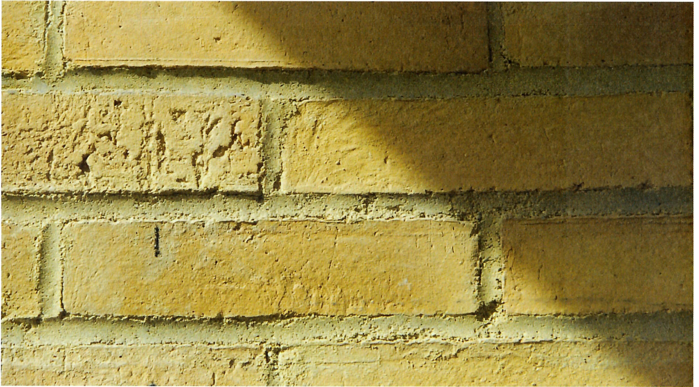
Gule, blødstrøgne mursten opført med trykket fuger under opmuringen. Blyantstregen har hjulpet mureren med at placere stenene i lod.
