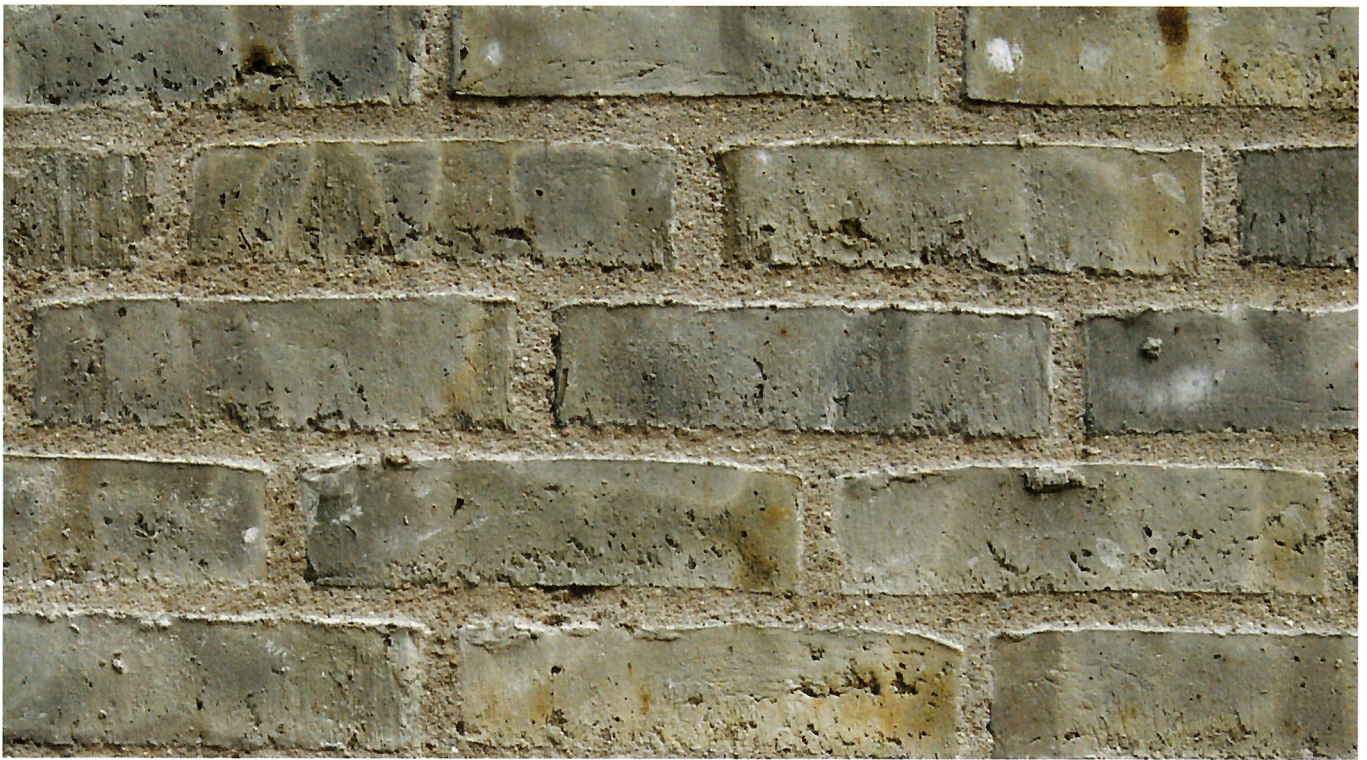
Grådæmpede mursten fuget med skræbefuge med indfarvet mørtel.
