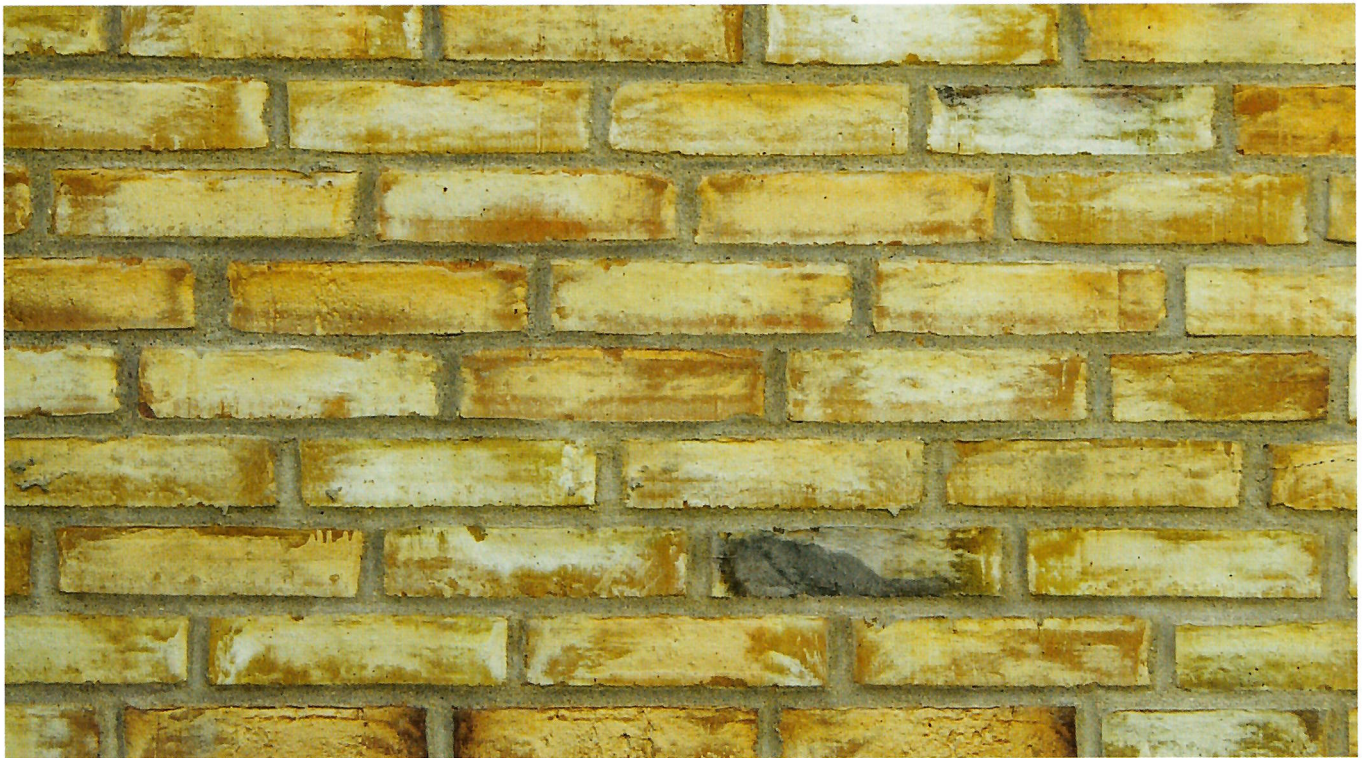
Gule, engoberede mursten. Inden stenene brændes oversprøjtes de med et lag opslemmet ler, hvilket giver overfladen et særligt spil. Engoberede sten må ikke afsyres.
