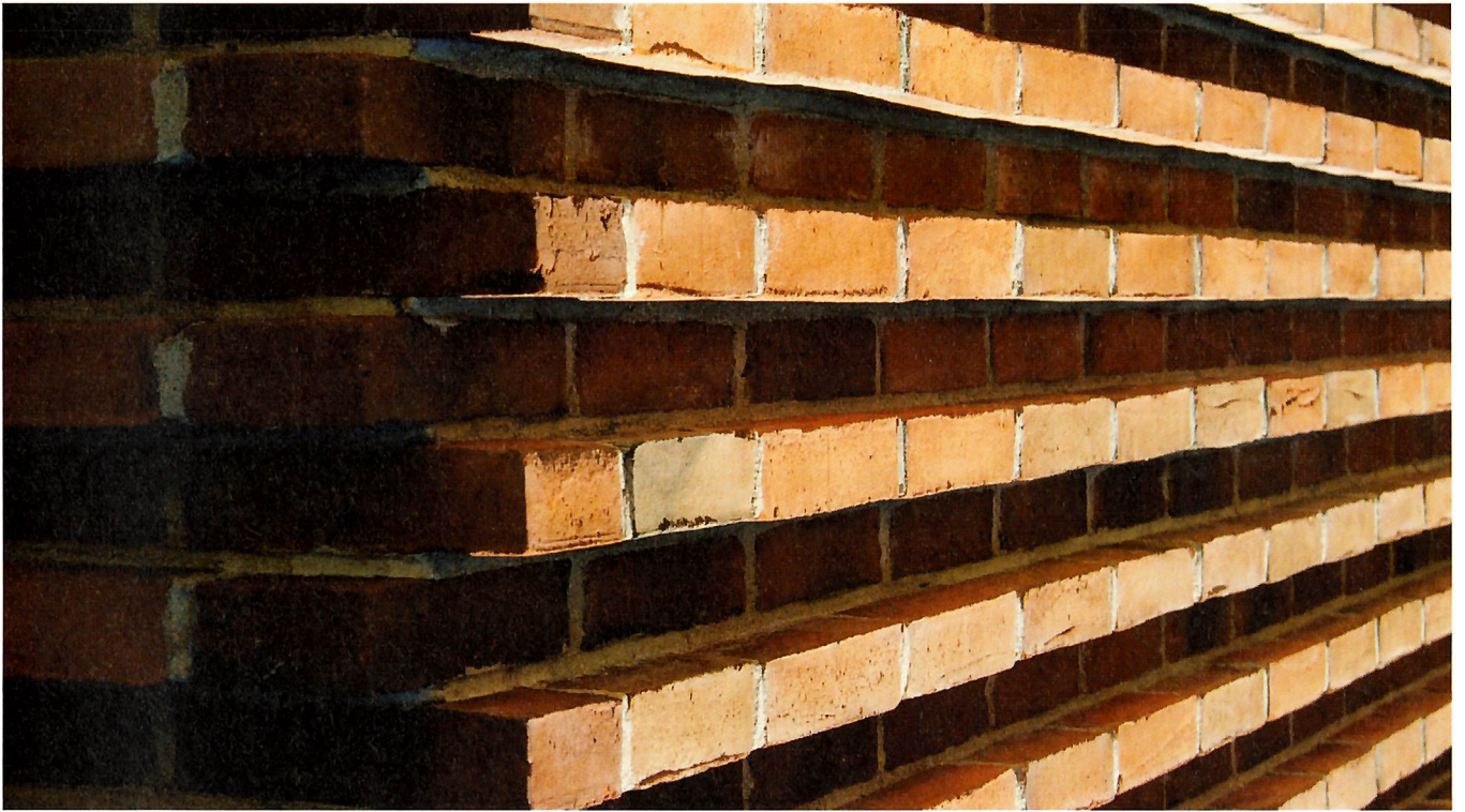
En kombination af bredsten og almindelige mursten danner et kraftigt relief i facaden. Udsnit af facaden på transformatorstation ved H.C. Ørstedsværket af Gottlieb & Paludan.
