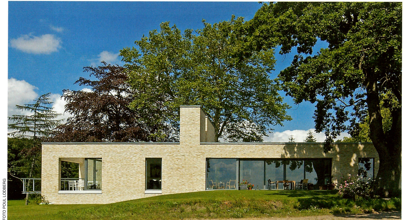
Engoberede mursten fuget med hvid fuger i enfamiliehus i Hjørtshøjlund af One end Design og Poul Lodbergs tegnestue.
