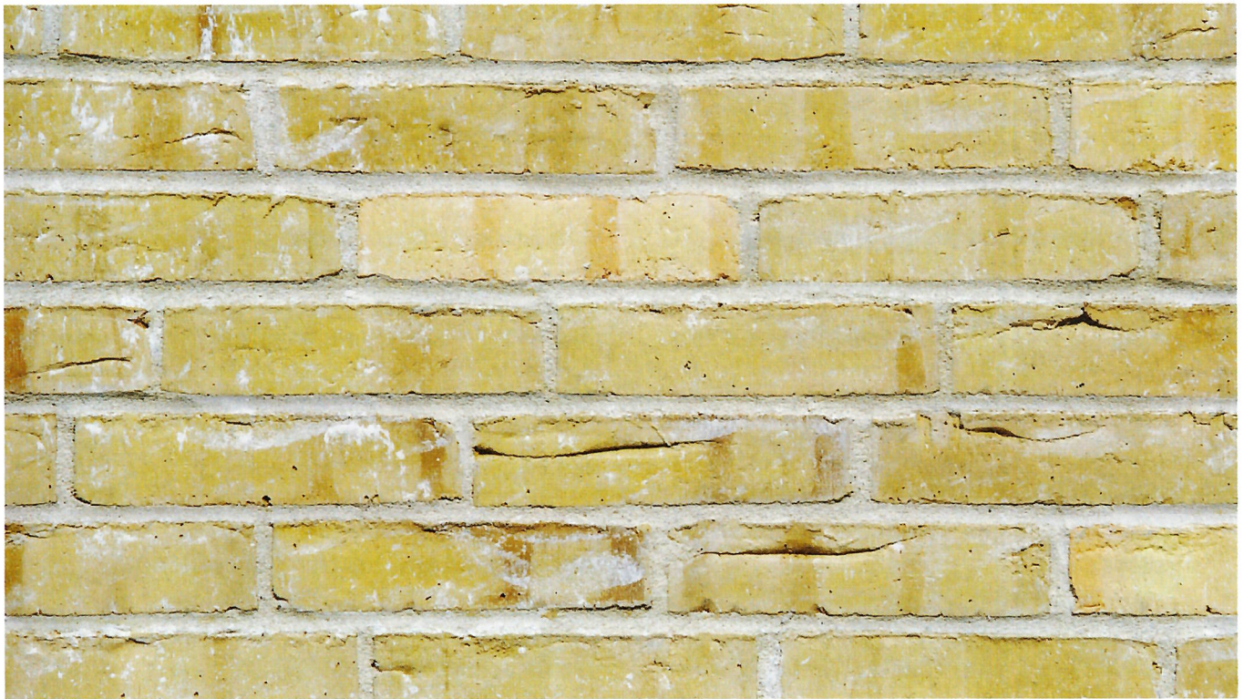
De gule, rustikke mursten med spil er muret i løberforbandt med trykket fuger. Murværket er ikke afsyret.
