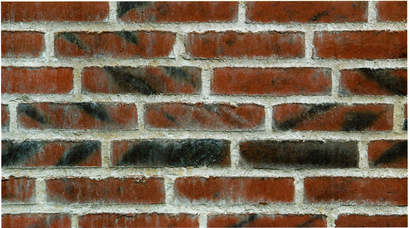
Mørke, røde mursten med sortflammet overflade, som ikke er afsyret. De mørke partier fremkommer i forbindelse med brændingen.
