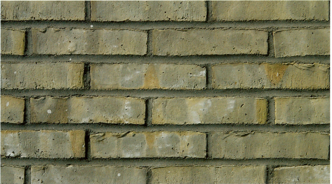
Grådæmpede mursten opført i indfarvet opmuringsmørtel. Fugen er trykket og færdiggjort under opmuringen.
