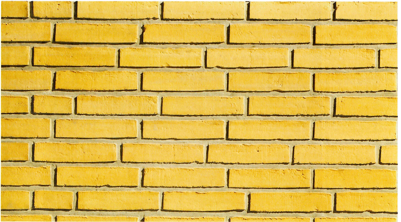
Gule, blødstrøgne mursten opført i 1/4-stens løberforbandt. Fugen er udkradset under opmuringen. Fugen er udført 5 mm tilbageiggende med en lys strandmørtel.
